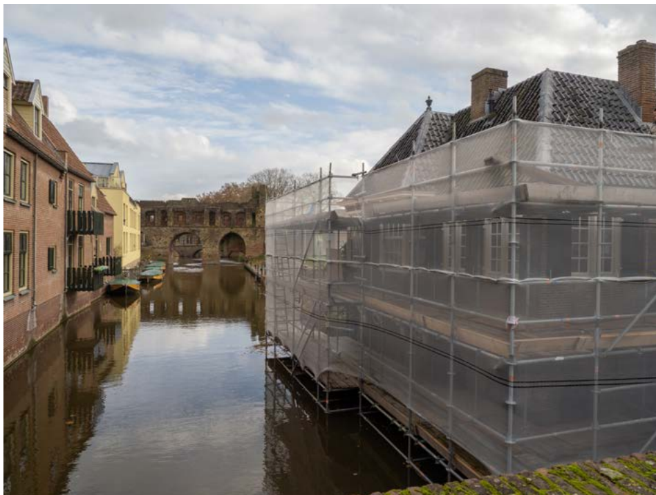
Schilderwerkzaamheden Rijckenhage 1. Foto: Jan van Dalen Fotografie
