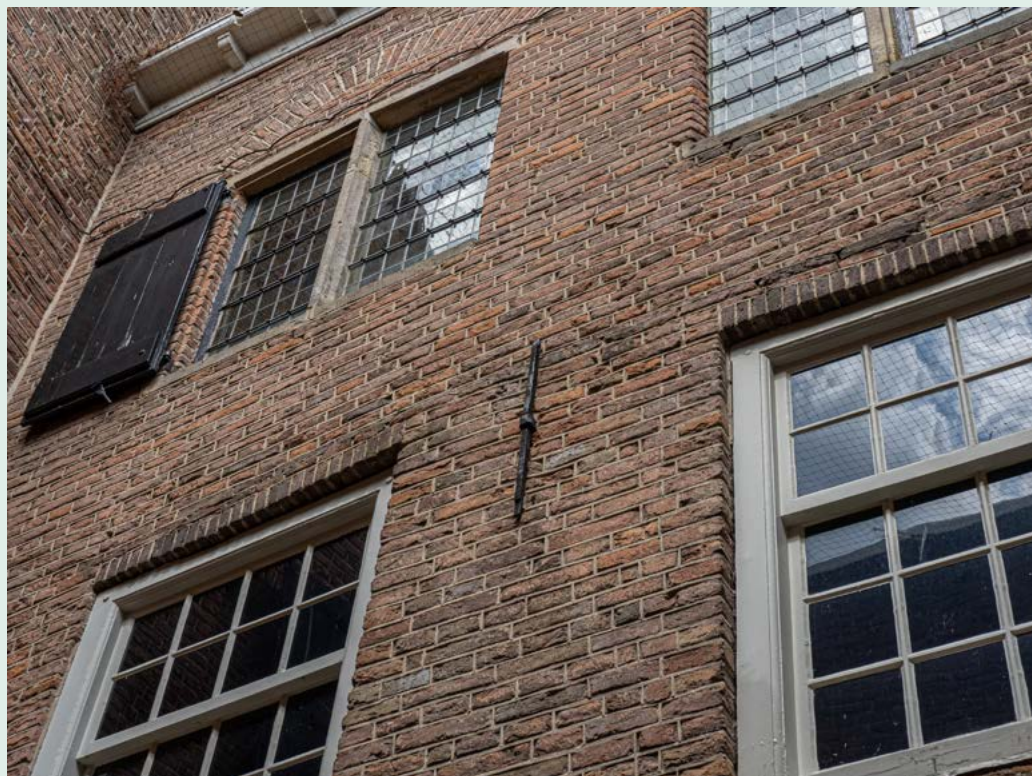
Gevel binnenplaats De Wildeman – Zaadmarkt 88. Foto: Jan van Dalen Fotografie
